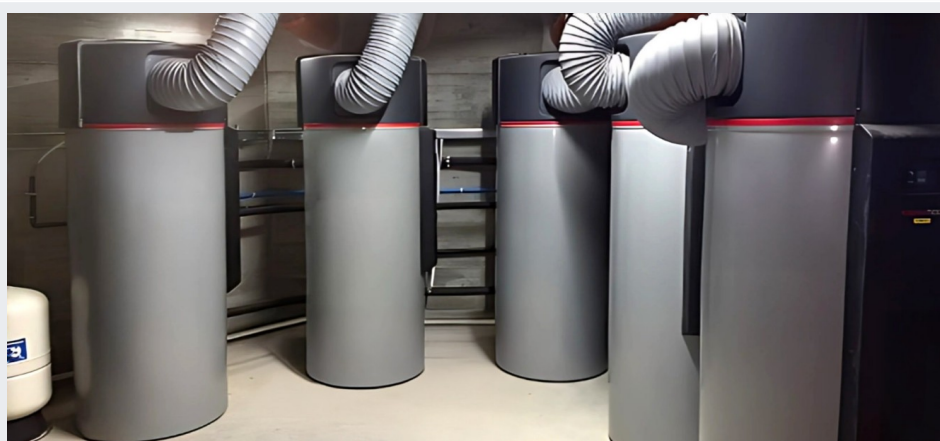
Συστοιχία πέντε μονάδων SMAX 450 με αεραγωγούς. Παράλληλη υδραυλική σύνδεση κατά τις οδηγίες του κατασκευαστή.
