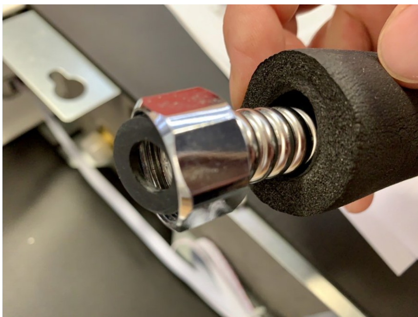
Τοποθετήστε τα στεγανοποιητικά παρεμβύσματα σε κάθε σύνδεση.
