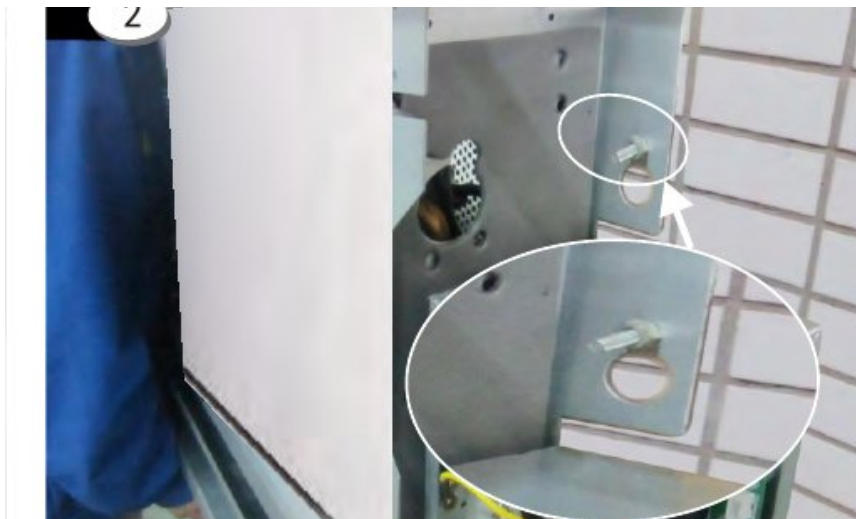
Στερέωση των μεταλλικών συνδέσμων (ούπα) στην αριστερή και δεξιά πλευρά.
