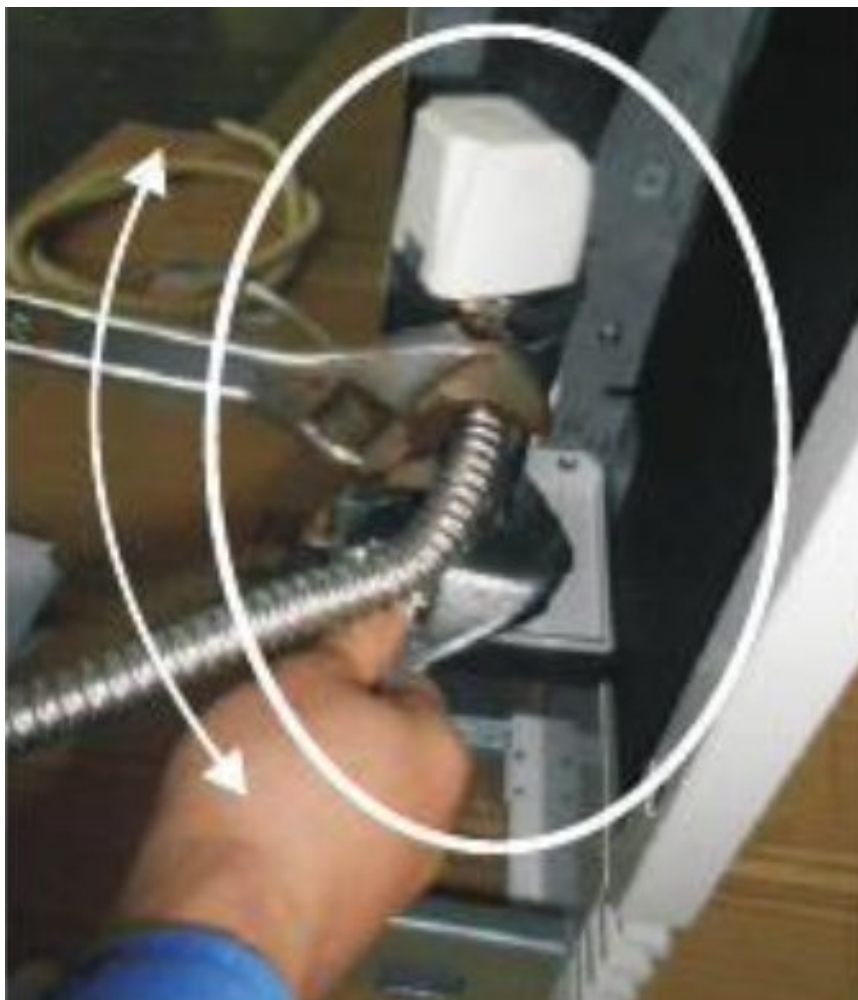
Σύνδεση του σωλήνα αποχέτευσης: το μικρό άκρο στον δίσκο συλλογής συμπυκνωμάτων και ασφάλιση με τον δακτύλιο σύσφιξης.
