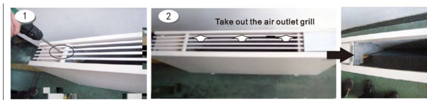
Εικόνα – Αφαίρεση της γρίλιας εξόδου αέρα
